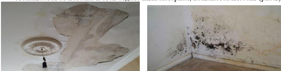
Рис.2. Разрушение жилых помещений талой водой, стекающей с крыши
