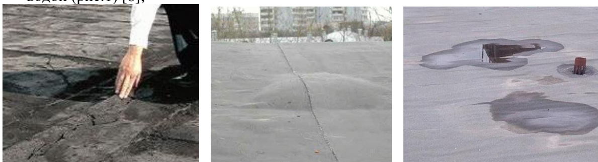
Рис.1 Результат воздействия атмосферных осадков на мягкую кровлю крыши: расслоение и трещины, пузыри, воронки с водой
